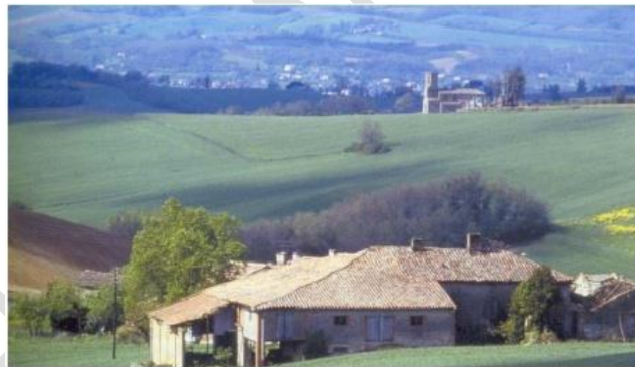
Source : CAUE Tarn
