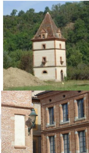
Pigeonnier (Saint-Lieux-Lès-Lavour) - Architecture en briques pour une palette de couleurs chaudes historiques (Lavour)
