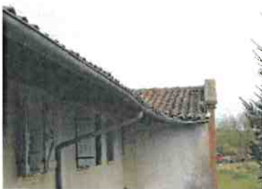
Enduits qui ne protègent plus la façade par endroit
