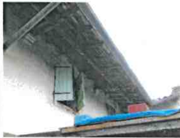
Vue sur la gouttière en zinc
