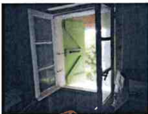
Fenêtres en simple vitrage
