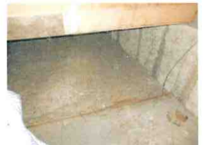
Vues sur la partie combles perdus sur le 2 ème étage
