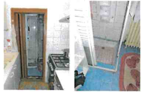
Vue sur l'accès de la douche au RDC
