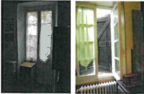
Fenêtres des pièces de vie en bois simple vitrage
