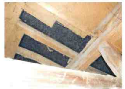
Vues sur la charpente et la couverture refaite
