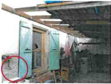
Enduits qui ne protègent plus la façade par endroit
