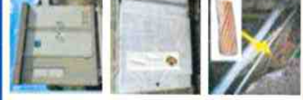
Câble de cuivre nu (retour à la terre : risque électrique)
