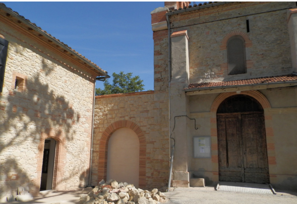
VUE DU SUD, À GAUCHE LE PRESBYTÈRE, À DROITE L'ÉGLISE
