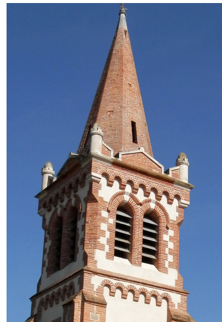
PARTIE HAUTE DU CLOCHER
