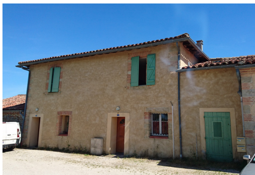
PRESBYTÈRE, VUE DU NORD
