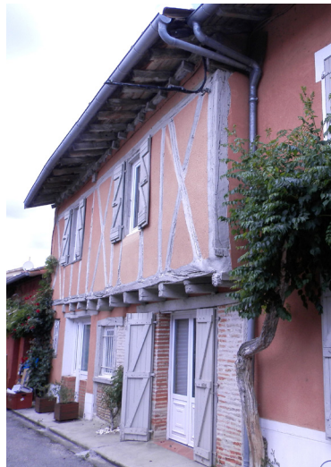
MAISON EN ENCORBELLEMENT (N°6 RUE DU CASTELAS)
